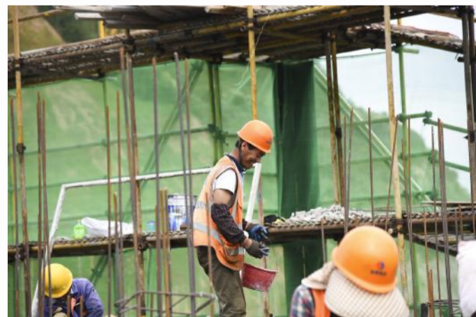
快乐的钢筋工
