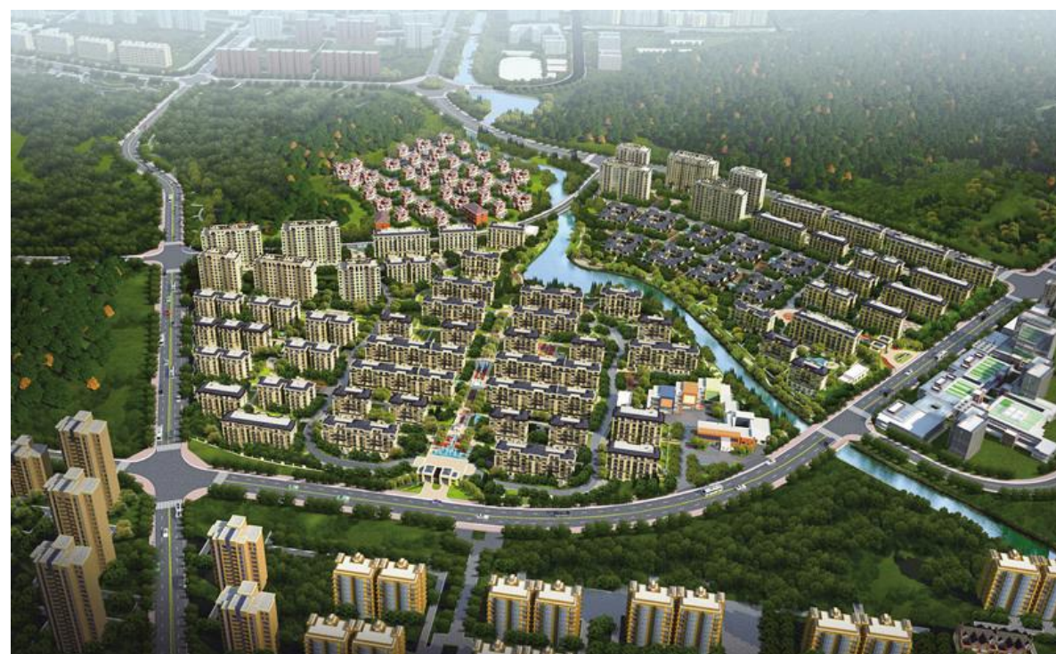
6、项目名称: 鲁家峙璞园 简介: 项目位于鲁家峙岛, 总建筑面积约为 79800 平米。 项目经理: 朱明国 袁成华 开 发 商: 舟山银亿新城房地产开发有限公司
