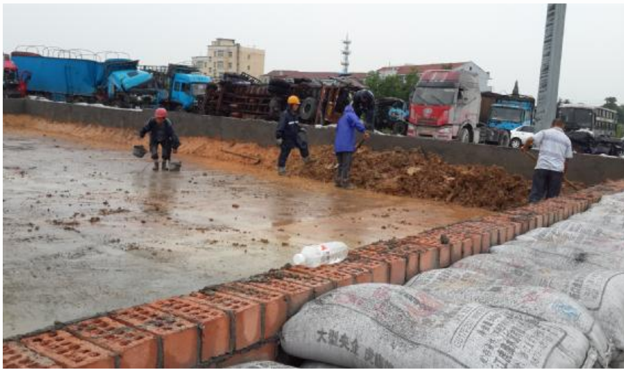
图为抢险现场
